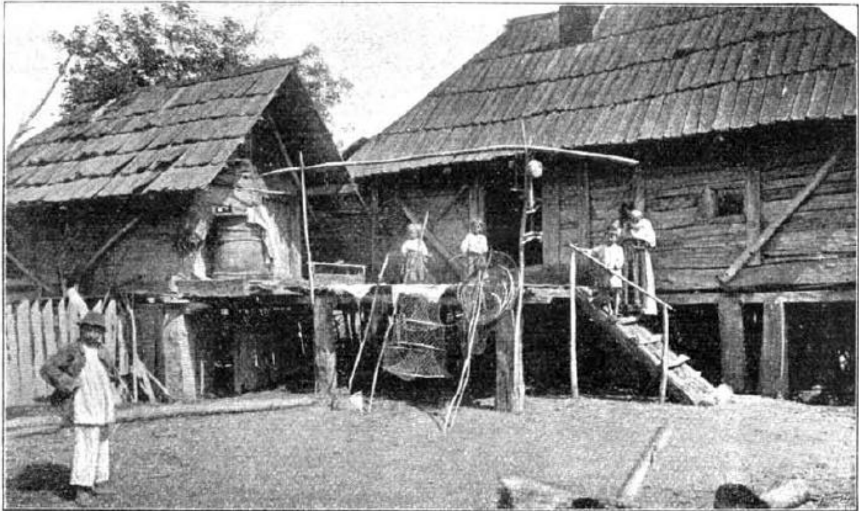
Slika 2. Kuća sa krovom „na dumu“ i zgrada u Gor. Dolini, kot. Bos. Gradiška.
