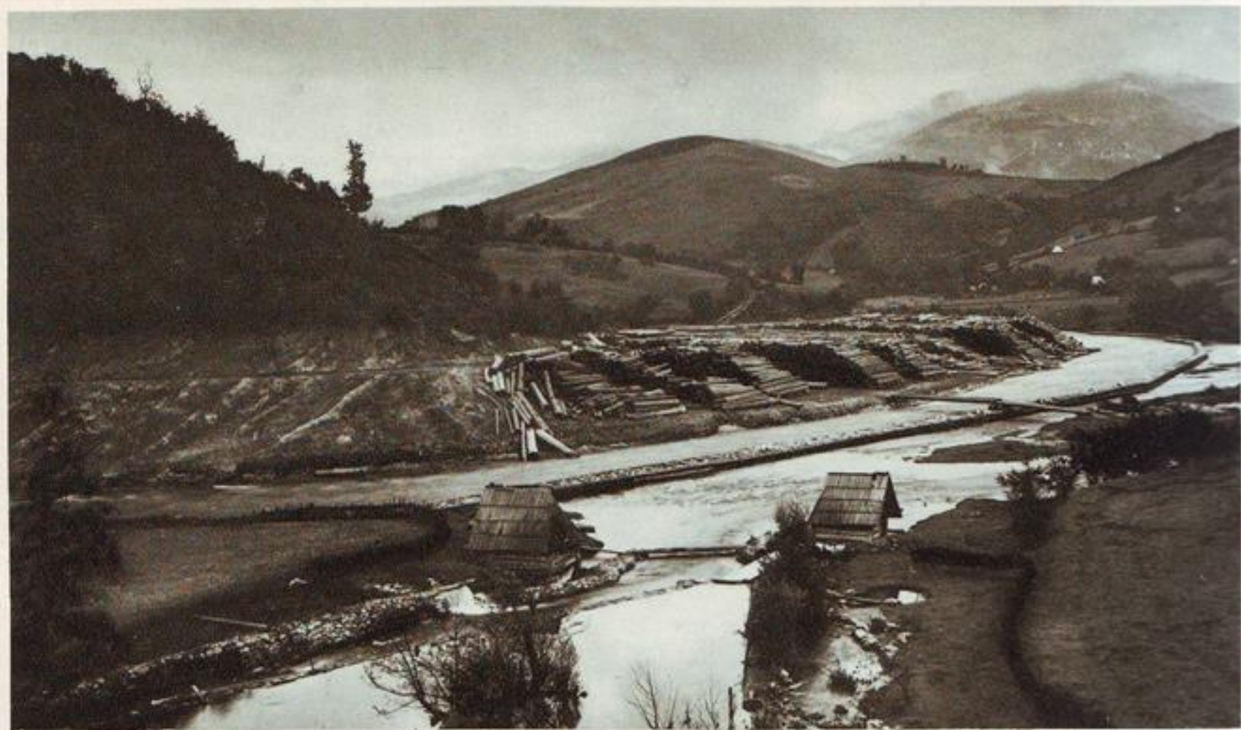
Dobrlin-Drvar, stovarište balvana na vrelu Ribnika, spremljeno za plavljenje
